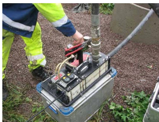
Puhalluslaite missä näkyy suoja-putki (vesijohtoputkea), paineilmaputki ja suoja-putkeen puhallettava kuitukaapeli (Lähde: Jorma Kohonen).
