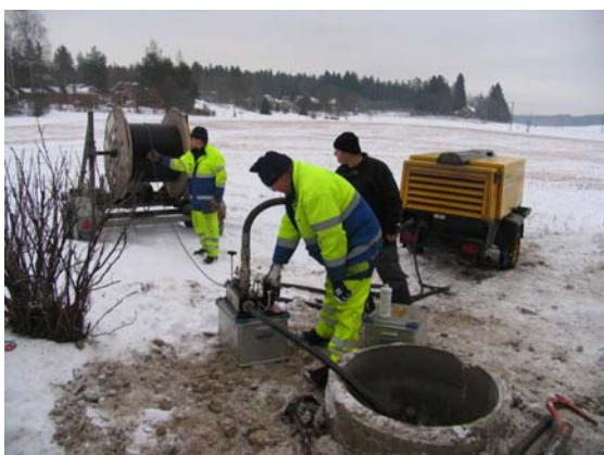
Kuvassa kaapelikela josta tulee kuitukaapeli, kelan pyörimistä jarruttelee tai antaa vauhtia apumies, painekompressori, puhalluslaite ja kaivo josta suoja-putki tulee ylös (Lähde: Jorma Kohonen).
